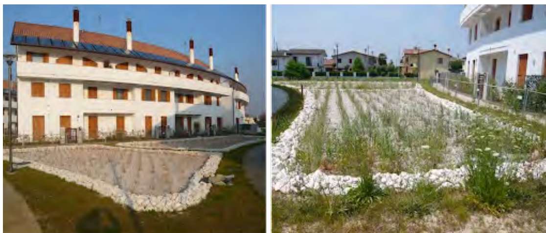
Figura 26: Fitodepurazione acque grigie Preganziol (TV). Fonte: http://www.igidra.eu/
