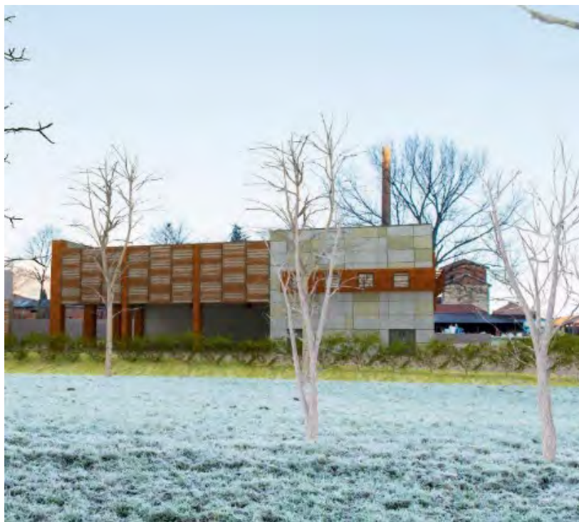
Figura 53: La centrale di teleriscaldamento di Barge (CN), cofinanziata con il crowdfunding. Fonte: LaGuida.it
