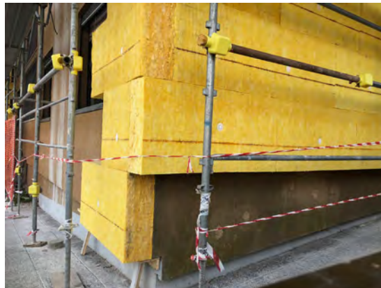
Figura 41: Esempio di installazione di alto spessore di isolamento con sola tassellatura e senza incollaggio né preparazione del substrato. Fonte: Progetto EU-GUGLE, Ristrutturazione edifici ERP Chiaravalle, Milano.
