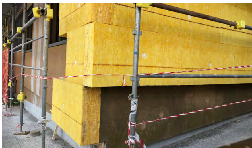
Figura 25: Esempio di isolamento esterno con 25 cm di isolante per consentire di utilizzare la massa dell'edificio come accumulo termico e creare "passive survivability" per 5 giorni in caso di Blackout. Realizzato in 5 edifici ERP del Comune di Milano, quartiere Chiaravalle, progetto EU-Gugle
